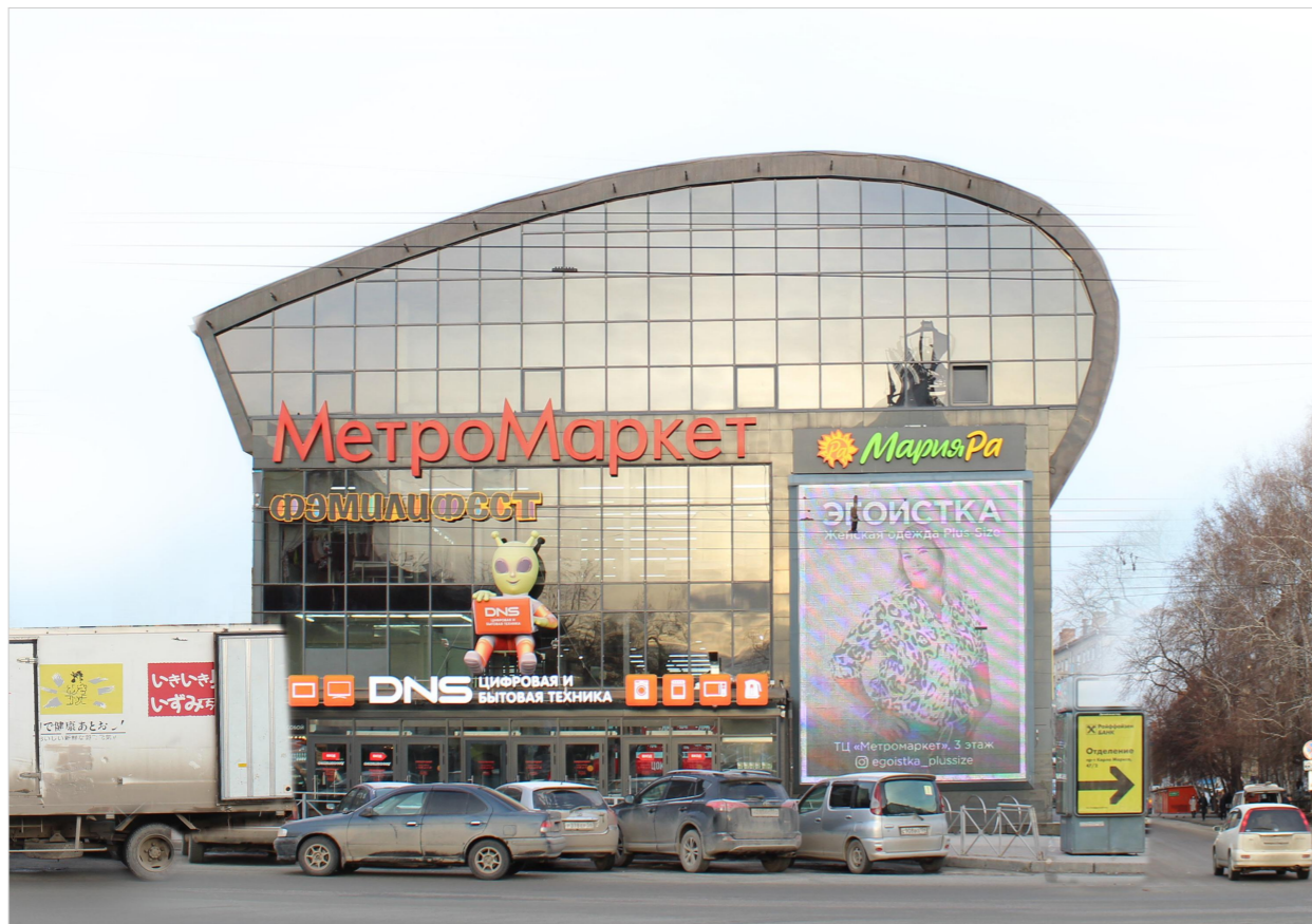
Главный фасад Д-А, выходящий на проспект Карла Маркса
